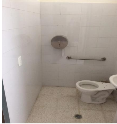
Adecuación de baños
